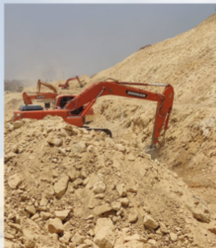
اعمال حفر وتكسير في تربة صخرية ذات اجهاد عالي
